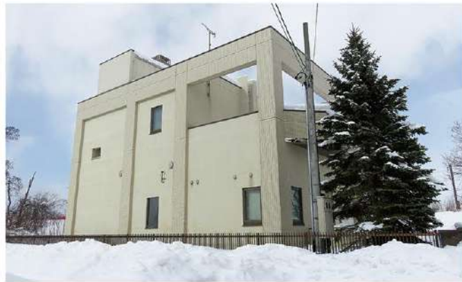
北斗ポンプ場
